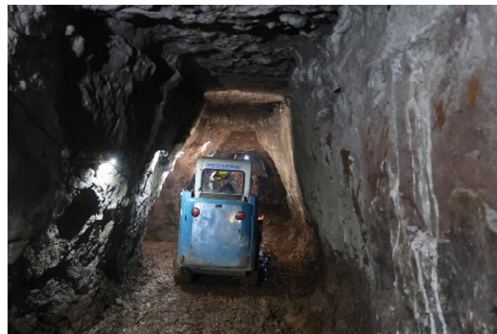
Die Arbeitstage gelten hauptsächlich der Stollenräumung.
